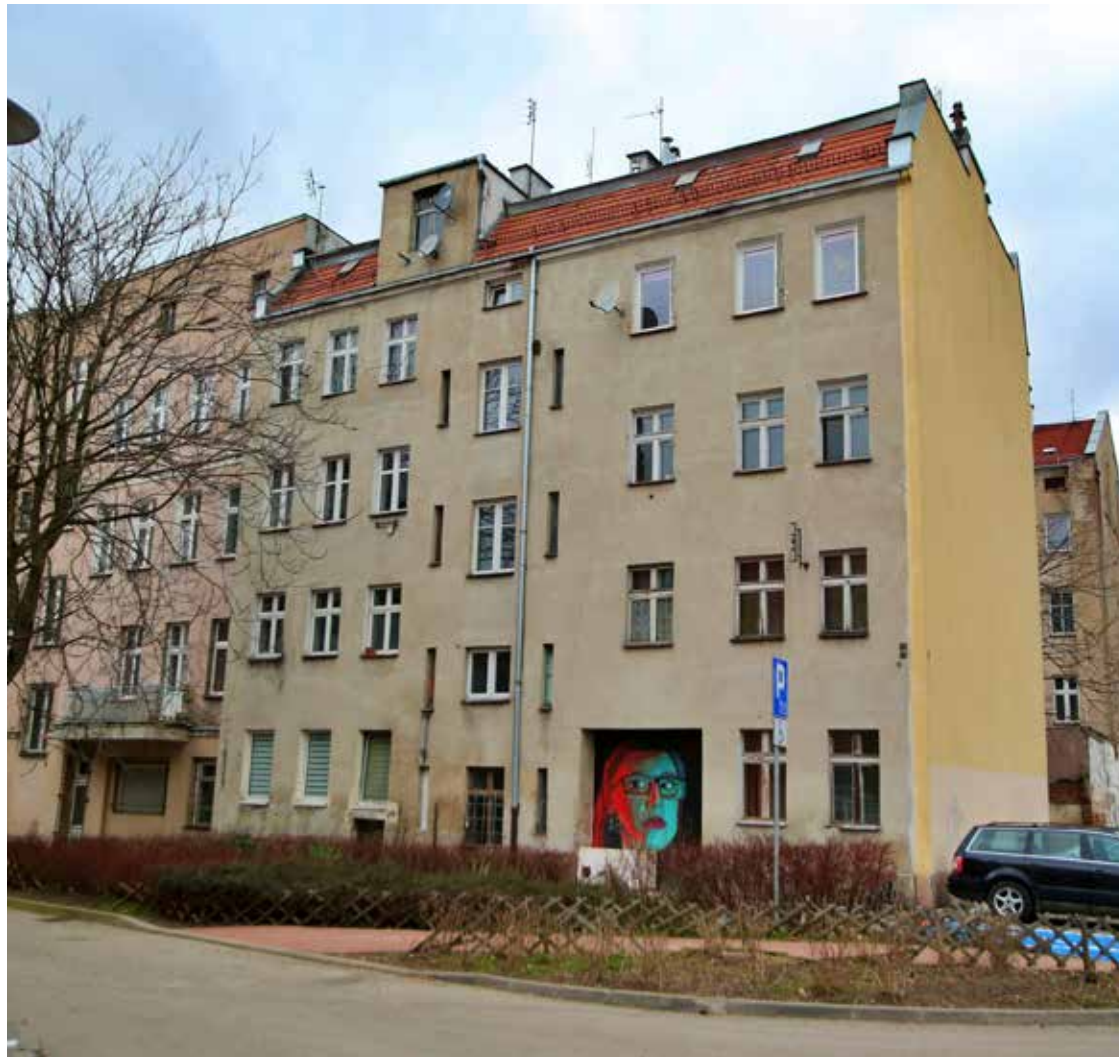
Kamienica przy ul. Otwartej nie była remontowana od 1995 roku, dlatego remonty są niezbędne
