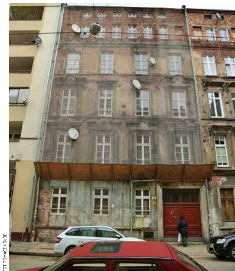
Najstarsza odkryta warstwa elewacji była jasnobieżowa
